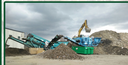
FASE DI LAVORAZIONE
